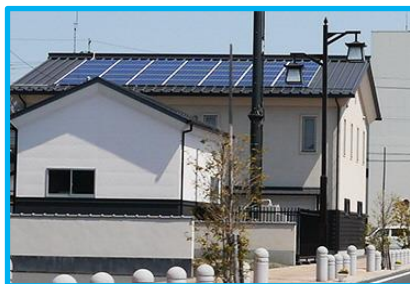
太陽光パネル（現防災センター）
