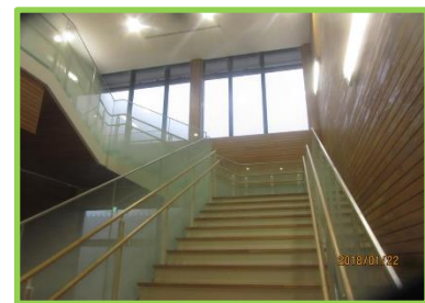
2本手すりの階段 (那珂川町)
