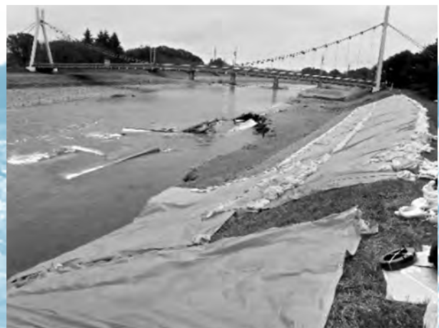
東雲さくら橋付近被災状況
