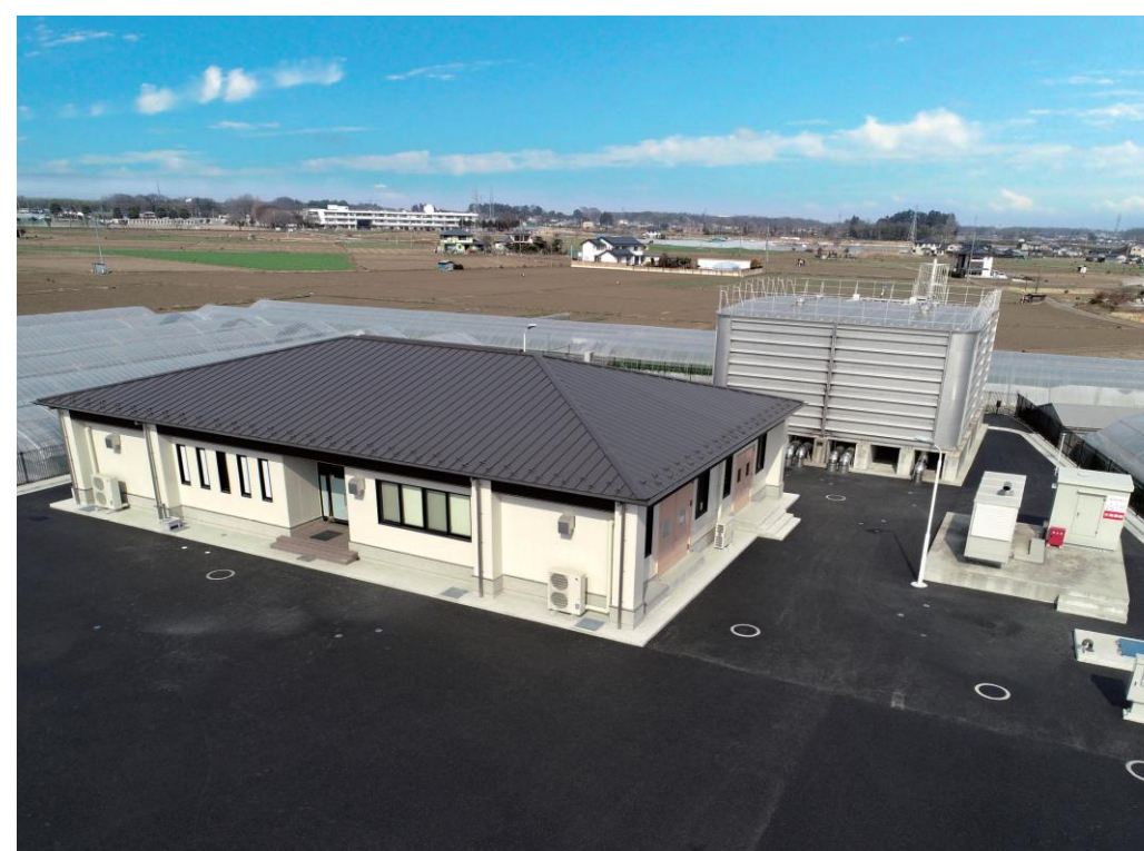
南部配水場 令和5年に建てかえました。
