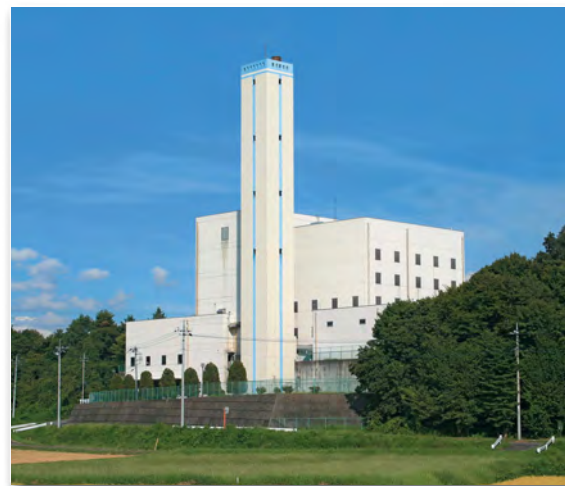
壬生町清掃センター全景
