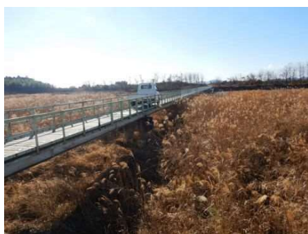
写真-5.1 側面全景
