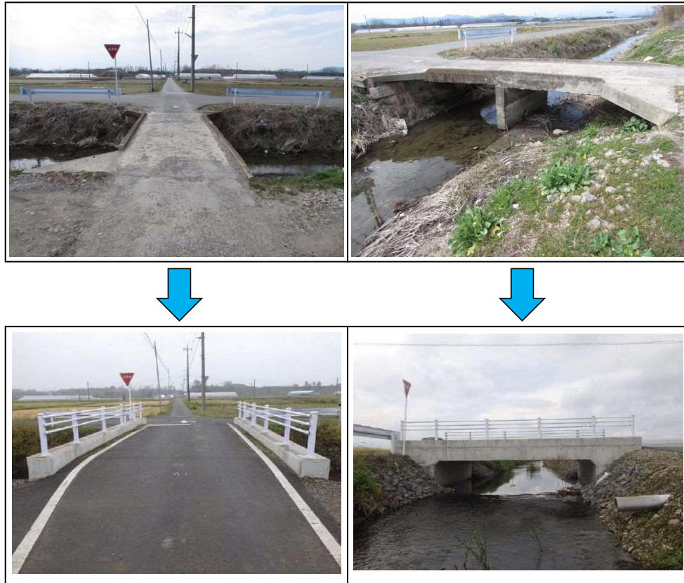
図-5.6 1225-2 号橋架替え状況
