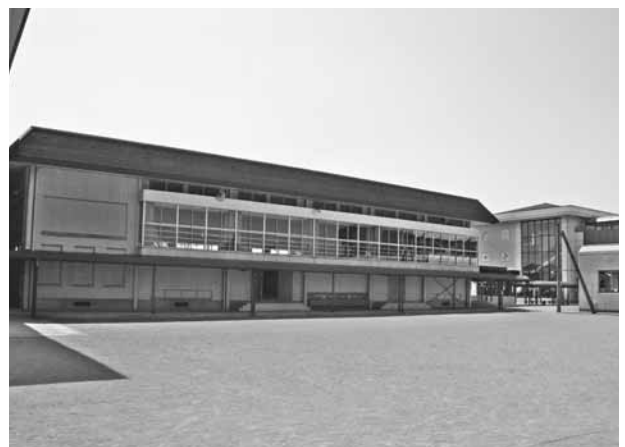
耐震補強工事が予定されている屋内運動場
