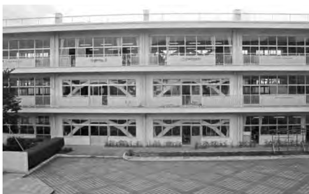
工事が完了した壬生東小学校北校舎
