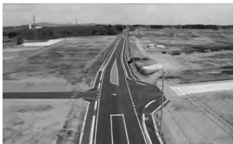
整備が完了した「一般県道羽生田鶴田線」
