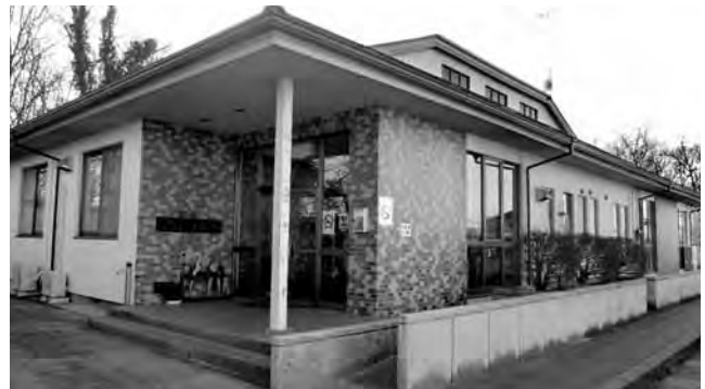
安塚地区コミュニティセンター外観
