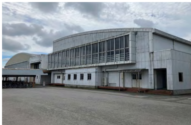
壬生中学校体育館（外観）
