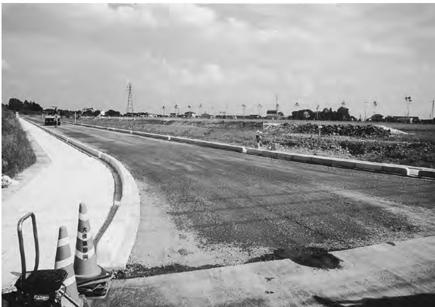
造成中のみぶ羽生田産業団地
