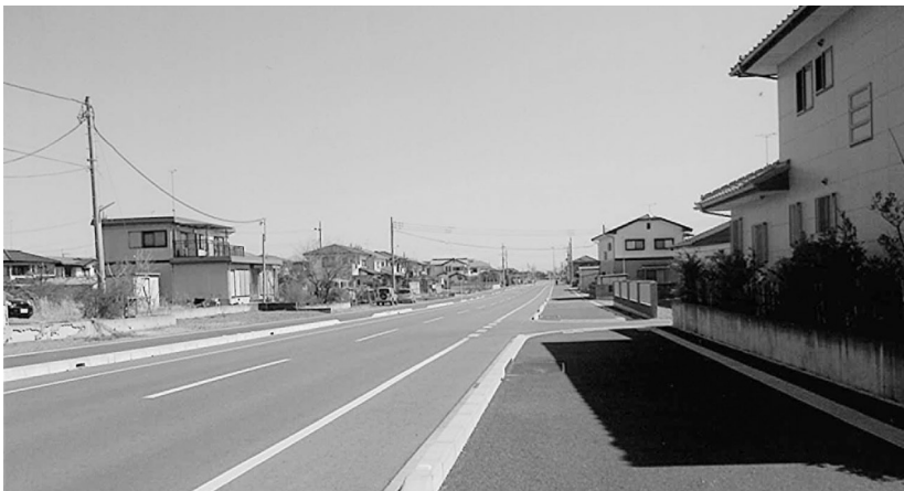
求められているLED防犯灯の早期設置
