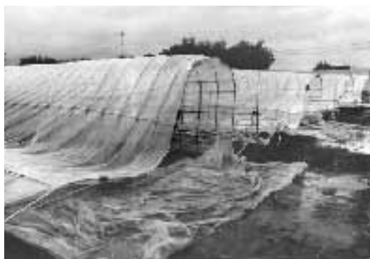
倒壊したハウス
