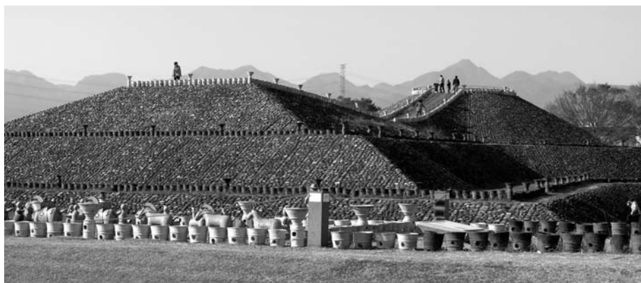
高崎市 復元整備した八幡塚古墳
