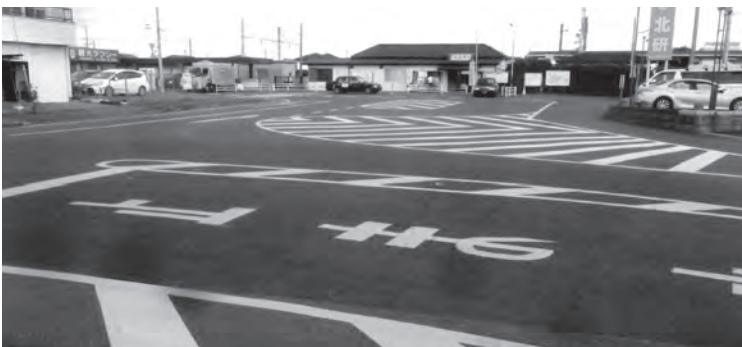
壬生駅西口前のロータリー
