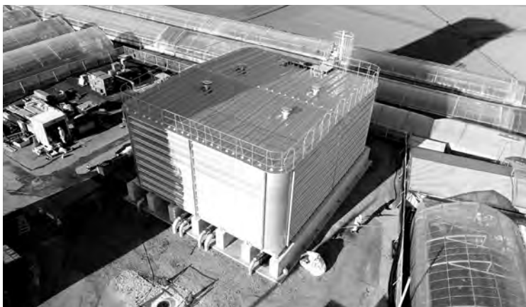
整備が進む南部配水場
