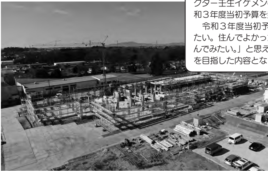
～新庁舎の建設状況～
