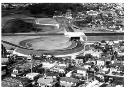
整備中の様子
