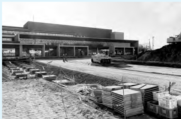
敷地北側 駐車場整備
