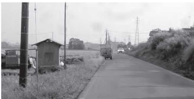
藤井地区の町道の状況
