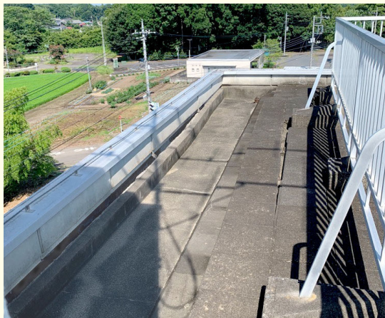
藤井小学校校舎屋上
