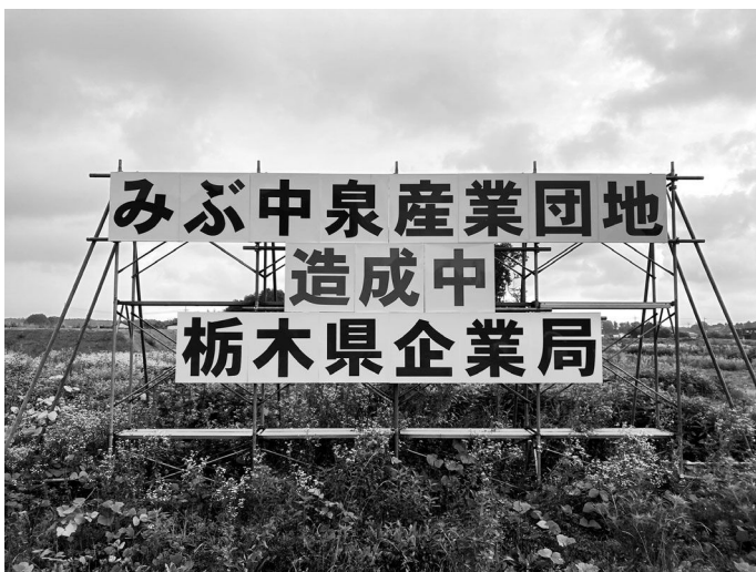
整備が進む「みぶ中泉産業団地」
