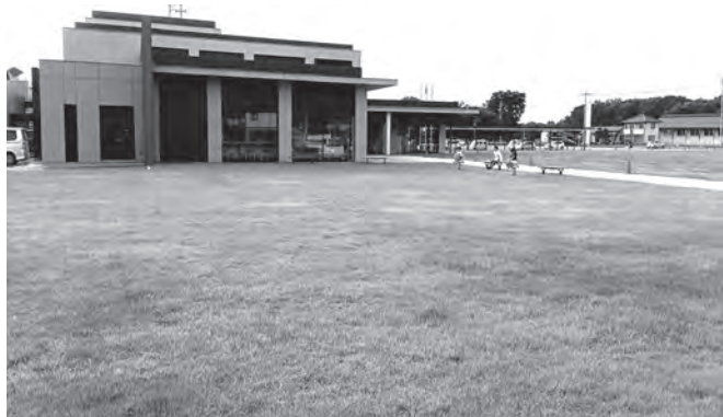
新庁舎の多目的広場
