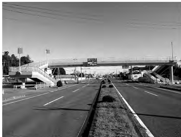
完成間近の写真 R4.12 撮影
