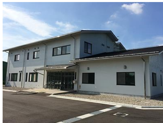
壬生町水処理センター
