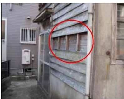
外壁の仕上材の一部がはがれ、 下地が露出している例
