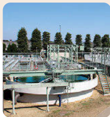
水処理センター
