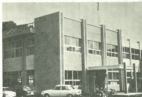
写真一完成した増築庁舎と(下)住民課の窓口風景
