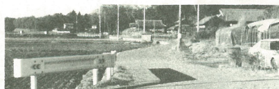
「くらしよい環境づくり」の一つとして道路の整備を行っています。昭和53年度の町道改良工事は5,541.9m、舗装工事は6,569.95mにのびりました。（写真は助谷地内の町道248-134）
