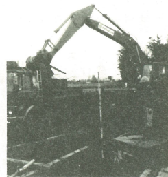
本管布設工事が進む愛宕前
