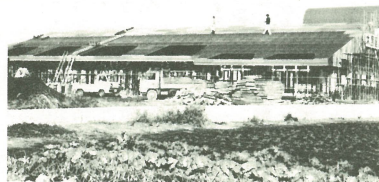
来年2月完成めざし南大館公民館南側に建設中の 町立第2保育所
