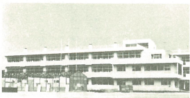
完成した安塚小(郵便局隣) 易保険創立金還元融資施設
