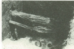
(土留めに用いた丸太と杭)
