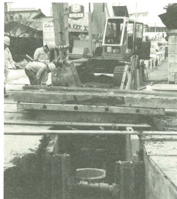
（進む下水道工事）
