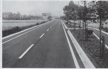
壬生中裏町道拡幅改良工事
