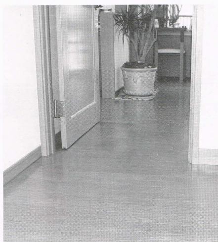
段差のない部屋の入口
